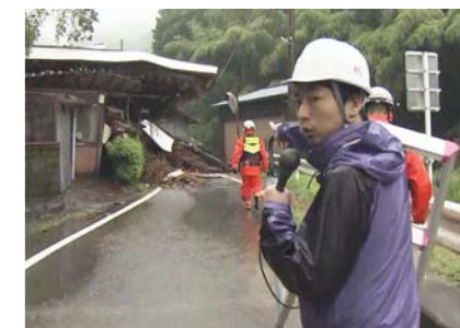
建物倒壊現場からレポートする記者
