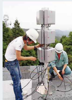
可搬式非常用UHFアンテナ
